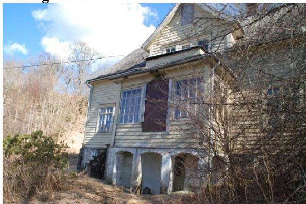
Figur 10 Huset er i god tilstand med unntak av altanen på framsida
