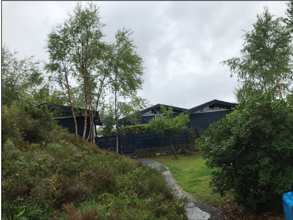
Eksisterande fritidsbustad på 121/74. Det er også etablert garasje i tilknytning til fritidsbustaden.
