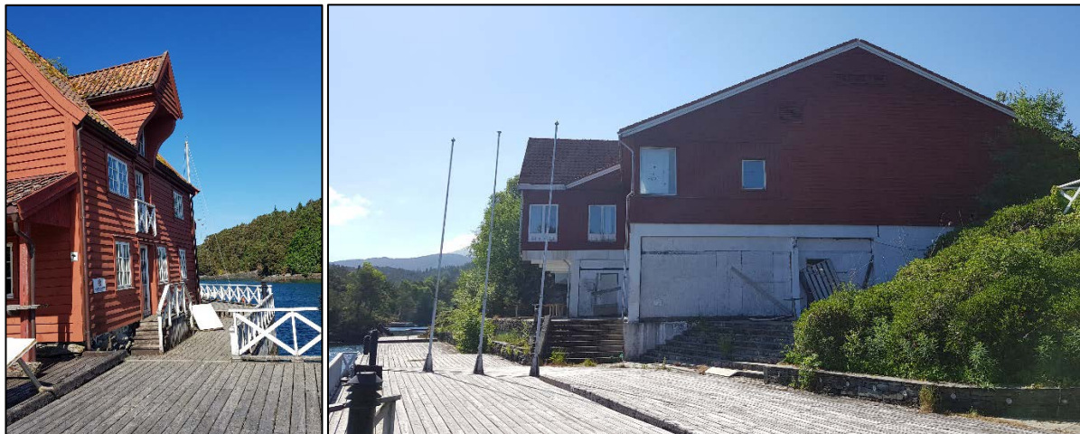
Figur 4 Eksisterande bygningar: Sjøhus og fjordhotell. Kjelde: Omega Areal as
