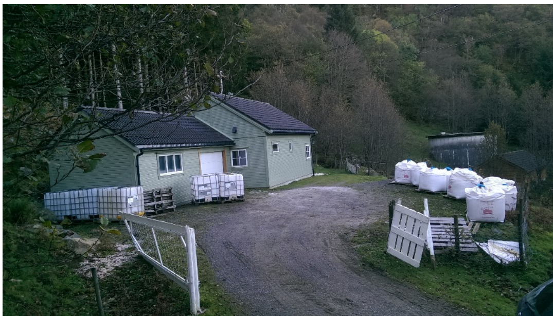
Figur 3-8: Uggdal vannbehandlingsanlegg med høgdebasseng i bakgrunnen.
