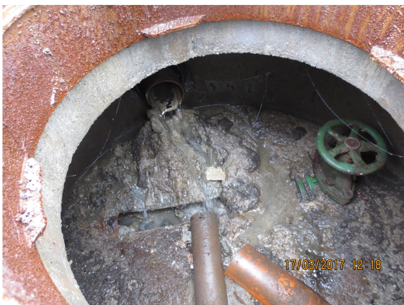
Figur 14: Bilete frå SP-kum i nærleiken av Lunde slamavskiljar. Antatt overløp frå slamavskiljaren kjem frå kl. 11 i biletet.
