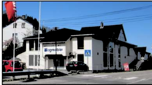
Gang- og sykkelveg aust for møbelforretning
