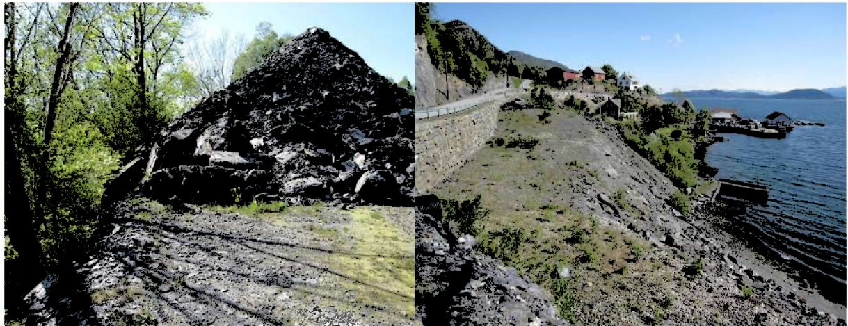
Figur 9: Til venstre deponi av steinmassar. Til høgre: Fylling langs fylkesvegen sett frå sør.
