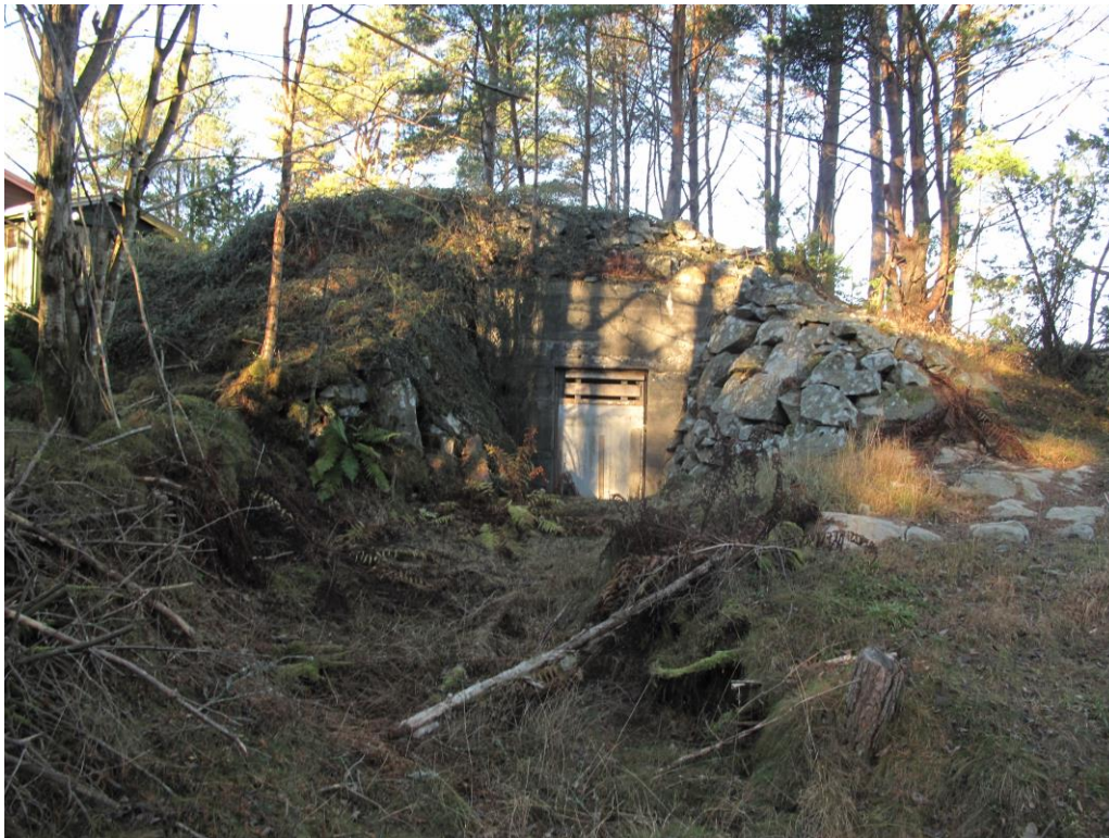
Rester etter bunkersanlegg
